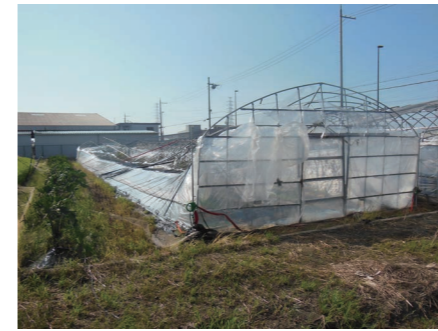
台風により被害を受けたハウス
