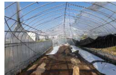
令和5年台風第7号による被害(泉南市)
